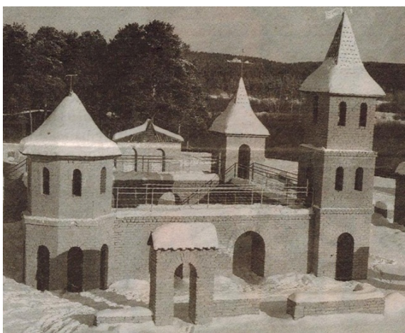
Участники сводного комсомольского студенческого строительного отряда в 1976 году, в качестве шефской помощи, на туристической базе «Арский камень» построили детский сказочный городок
